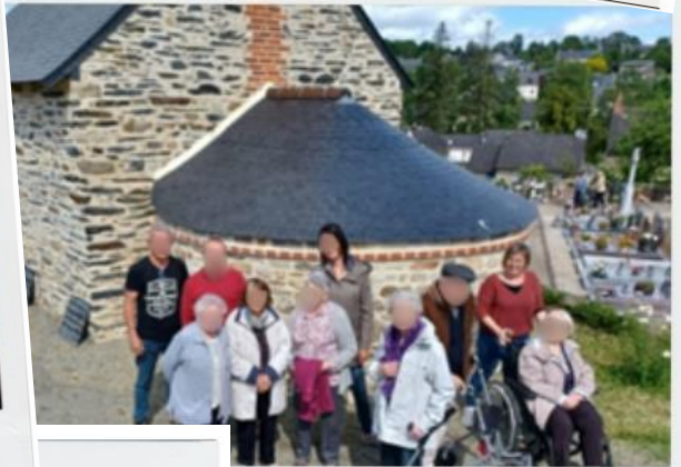
Visite du four à pain de Montreuil-Sous-Pérouse
