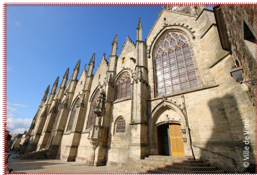
Façade latérale de l'église Notre-Dame
